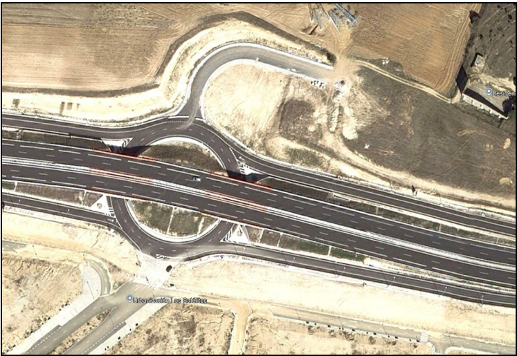
Ortofoto año 2009. Las obras de desdoblamiento de la M-503 y de acceso a las dos unidades de ejecución del sector se encuentran ya ejecutadas.
