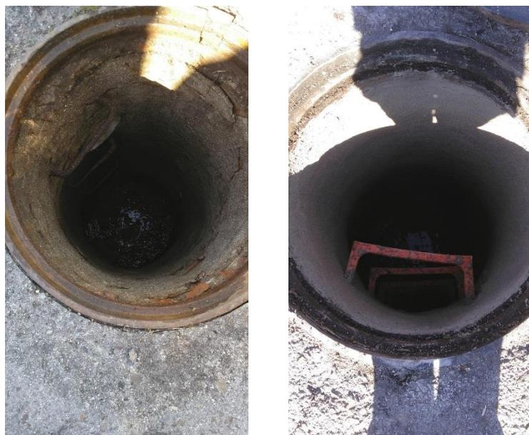
Además, cabe señalar la construcción de un nuevo colector en la calle Circe que sustituye al existente que se encontraba completamente deteriorado y prácticamente fuera de servicio.
