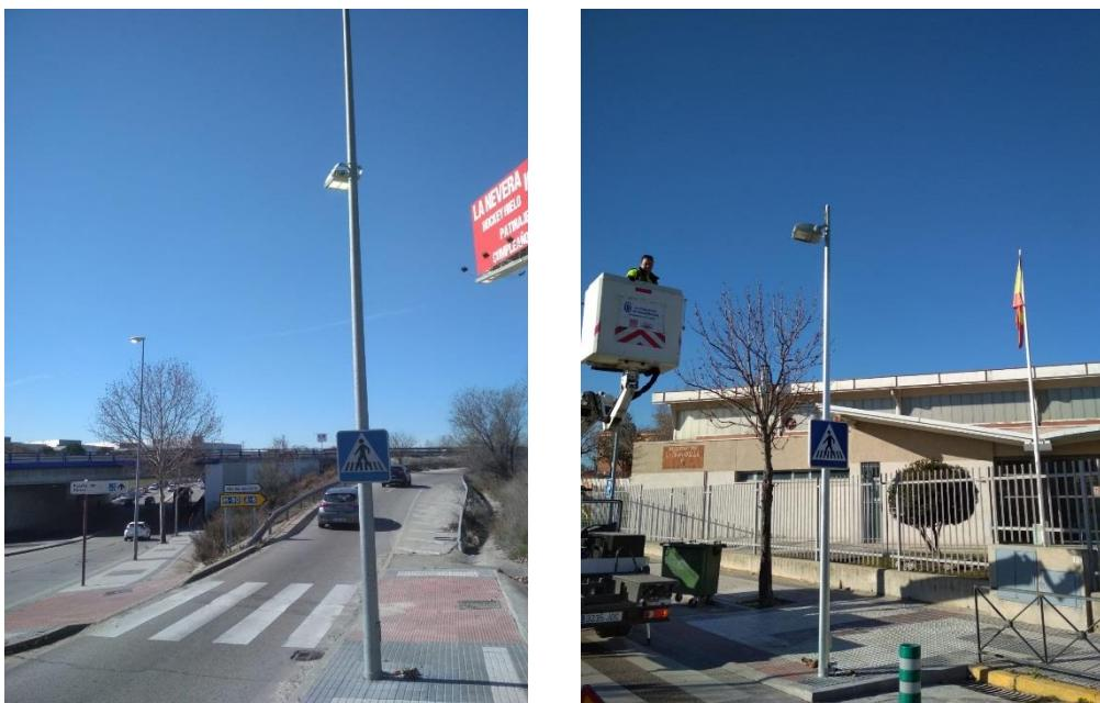
Dentro de la campaña continua de adecuación a normativa y mejora del alumbrado público, se destaca este mes la mejora de la iluminación del paso inferior de la calle Manuel de Falla bajo la M-503, mediante la implantación de proyectores led.
